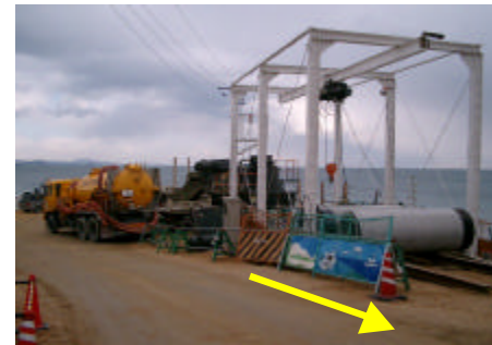
発進立坑全景
